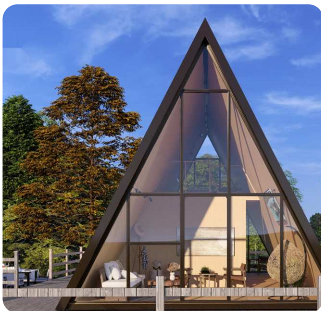
Dach und Tragwand bilden eine Einheit
